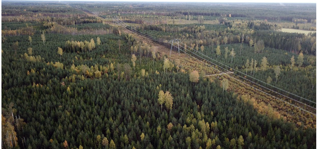
Den befintliga 400kV kraftledningen CL6 S1-2 som går igenom området.
