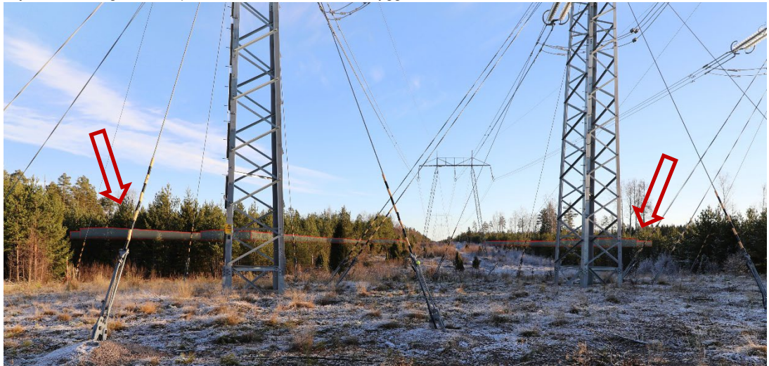
Vy genom kraftledningsgatan. Tillkommande byggnader markerade i rött. Foto: COWI 2019
