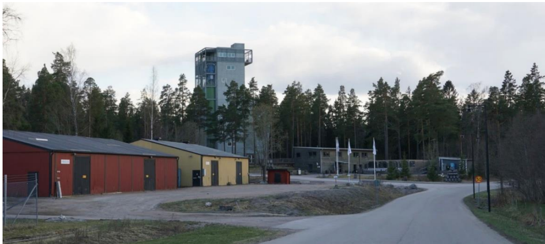
Figur 17. Utblick över befintlig bebyggelse inom planområdet längs Kungsbäcksvägen.
