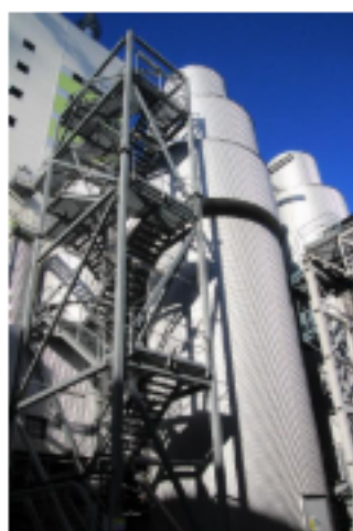
Slangfilter för rökgasrening
