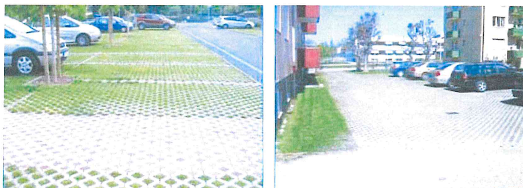
Figur 27. Exempel på gräsförsedd rasteryta vid parkeringar (Svenskt Vatten, 2011).
