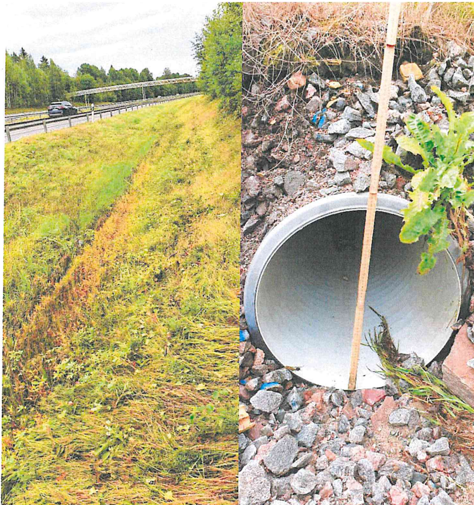
Figur 14. Fotopunkt 1 (t.v) visar vägdiket vid E4 vy mot syd. Fotopunkt 2 (t.h) visar en vägtrumma (D600) vid Kungsbäcksvägen.
