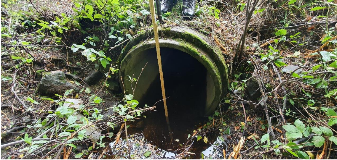
Figur 16. Fotoplat 5 visar vägtrumman som kommer ut öster om E4 (D800).
