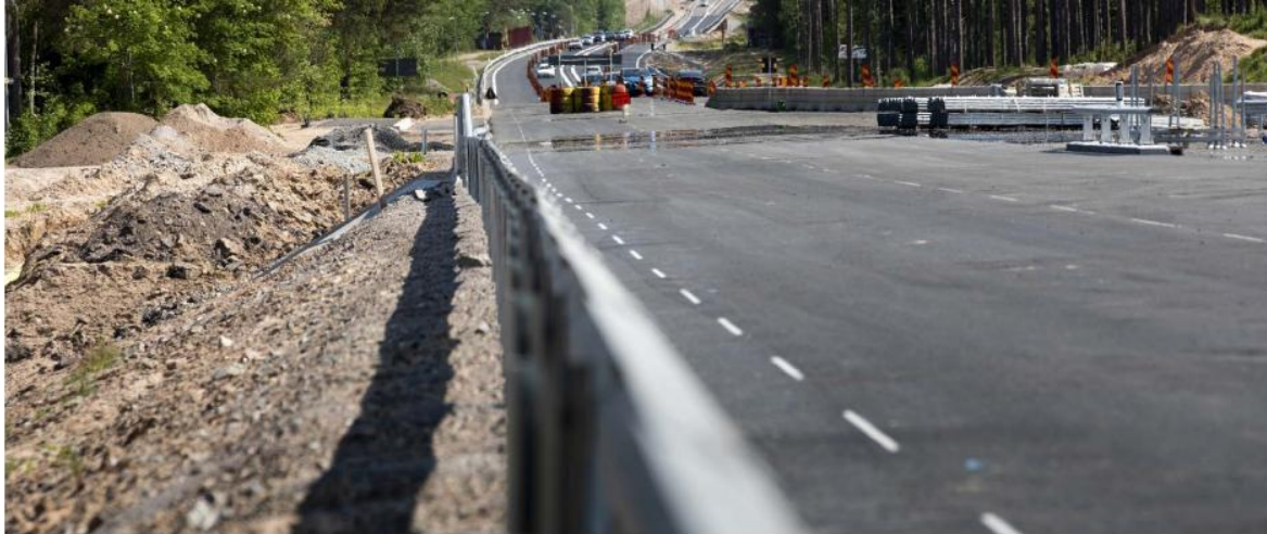
Ombyggnationen av E16 i Norr Amsberg under etapp 1.
