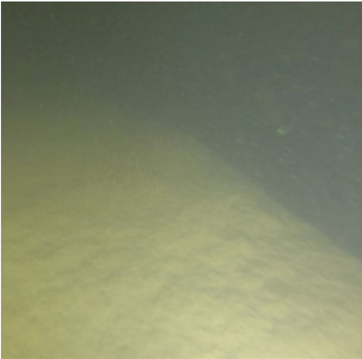
Figur 55. Block täckt av tjockt lager av sediment på 30 m djup. Centralt i bilden syns hydroider. Foto från UW Techs rapport.
