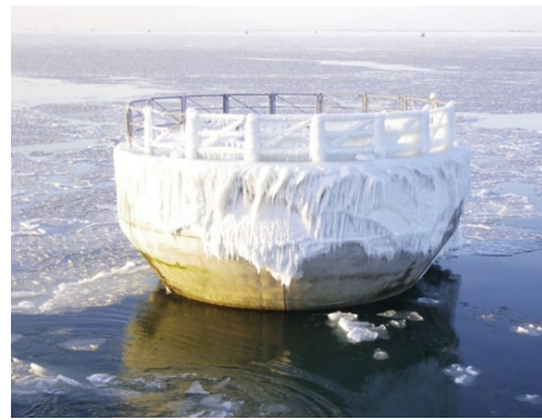
Figur 5. Betongarmering till gravitationsbaserat vindkraftverk (uppe v), transport av vindkraftverk (uppe h). Skiss på gravitationsfundament för havsbaserad vindkraft (nere v), iskon på gravitationsfundament (nere h) källa: Per Aarsleff A/S.
