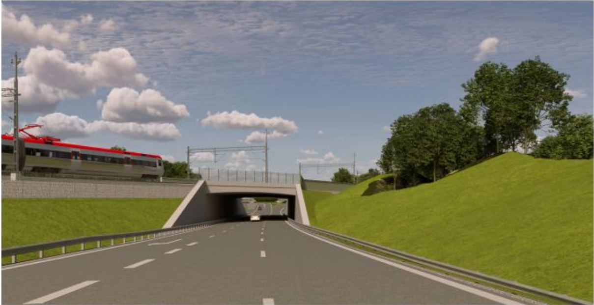
Figur 24. Järnvägsbro över Hamnleden sett mot öster.
