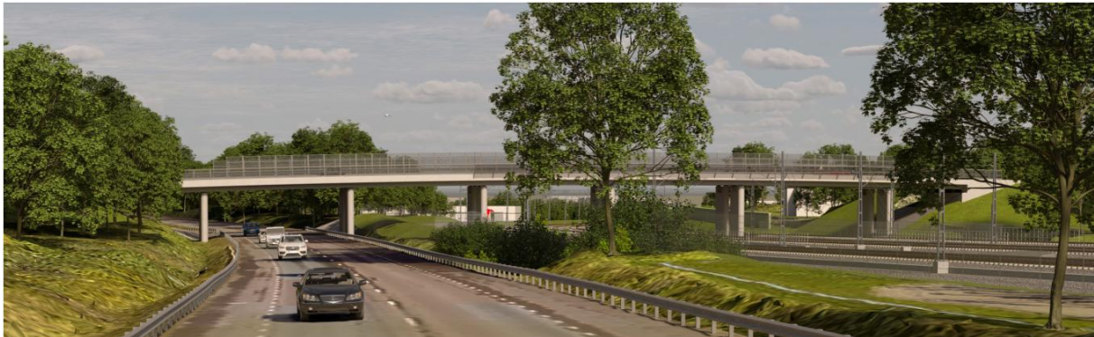
Figur 23. Skånbergsledens passage över Hamnleden och järnvägen sett mot öster.
