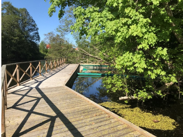
Dagvattenåtgärd (skärmbassäng) i Gavleån.
