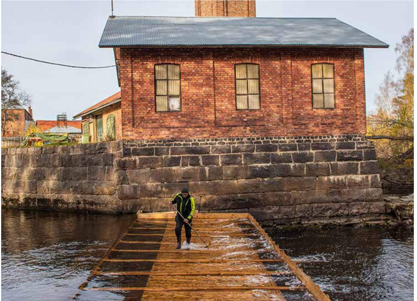
Ålfällan vid Forsbacka vattenkraftverk.
