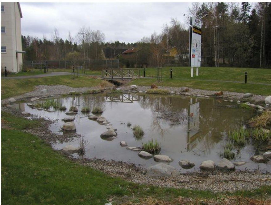
Figur 16. Exempel på en damm med vattenspegel (Sweco).
