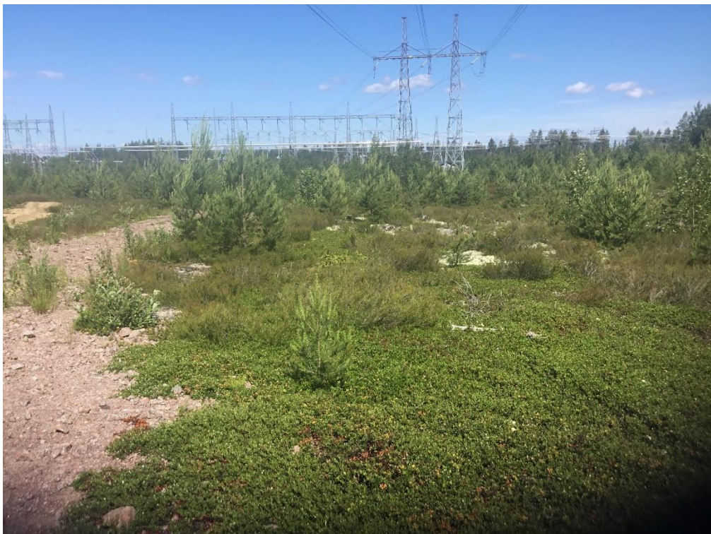
Figur 4. Kraftledningsgatan som löper genom området. I bakgrunden syns ställverket.
