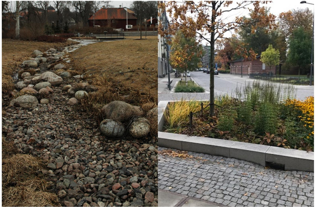
Figur 13. Inspirationsbilder. Tv Krossdike som integrerats med omgivning. T.h. plantering med träd till vilken dagvatten leds för rening och fördröjning.
