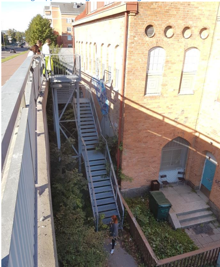
Figur 41. Befintlig gångtrappa mellan Muréngatan och Staffansbron, Kaserngatan.
