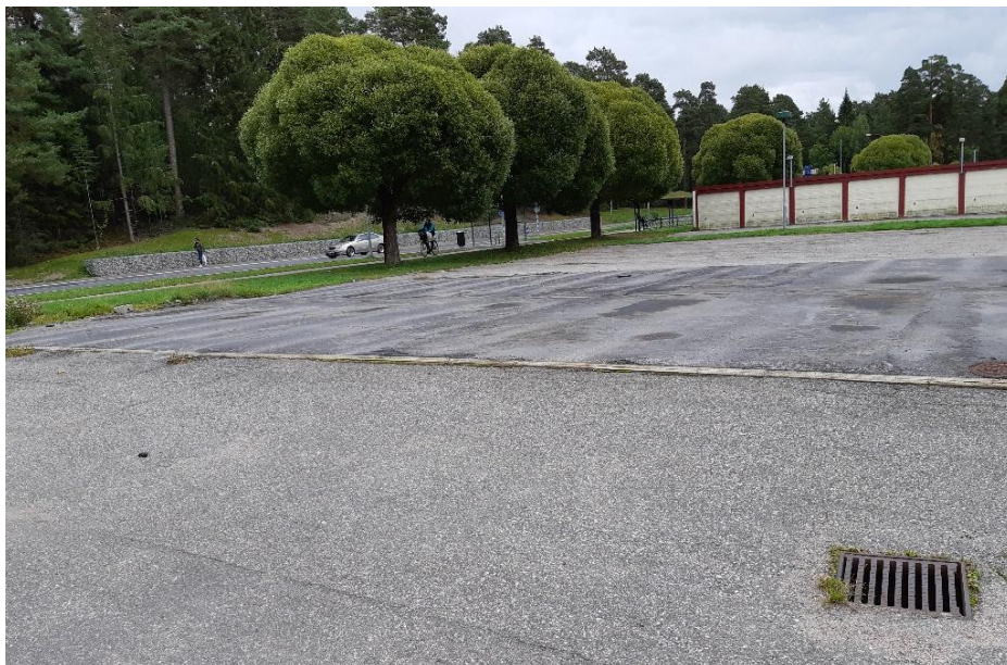
Figur 7. Befintlig markanvändning kv Kärran. Avvattnings sker till gallerbrunnar
