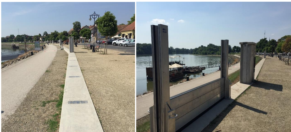
Figur 12. Exempel på mobilt översvämningsskydd med permanenta fästen (Zsentendre, Ungern, © Tyréns 2018).
