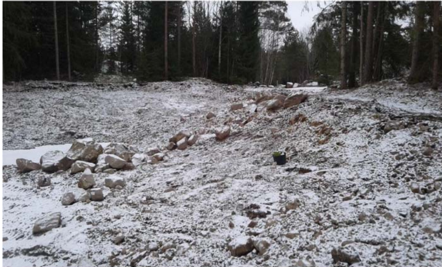
Figur 4. Östra delen av schaktgropen efter slutförd urgrävning (förutom i S5b längst bort i bilden, som slutfördes något senare). 2017-11-20.
