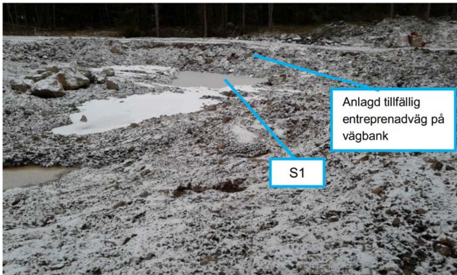
Figur 5. Västra delen av schaktgropen efter slutförd urgrävning. Längs bort syns ruta S1 efter ytterligare urgrävning av 0,3 m. I bakgrunden syns den tillfälliga entreprenadvägen. 2017-11-20.
