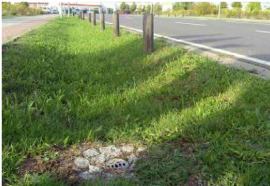
Figur 13. Exempel på infiltrationsstråk mellan väg och gångbana med upphöjd kupolbrunn (Stockholm stad, 2016).
