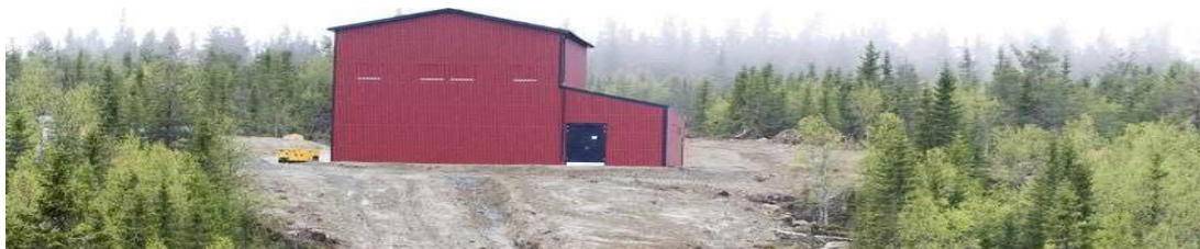
Figur 15. Foto över inomhusställverk vid Vattenfalls vindkraftsanläggning i Stor-Rotliden i Åsele kommun.
