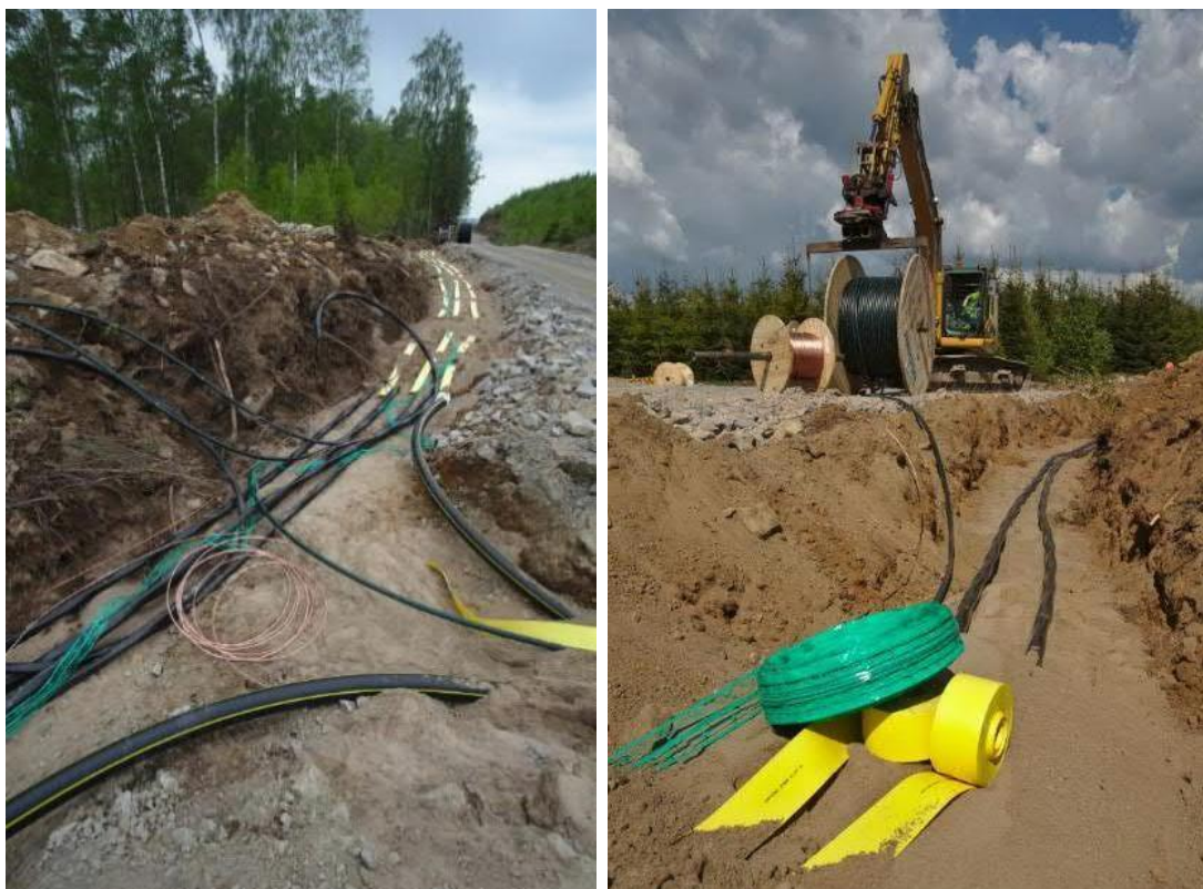
Figur 13: Kabelgrav med kabel och kommunikationsnät intill väg. Bild till vänster visar tre kabelradialer och bild till höger tre kabelradialer. Foto: Vattenfall
