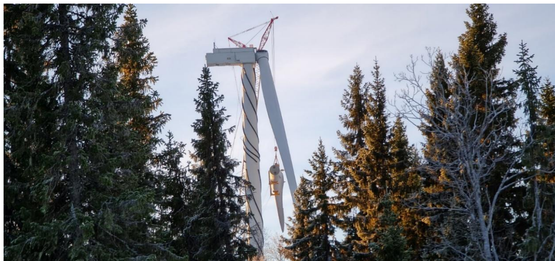
Figur 7: Montering av vindkraftverk vid Björkvattnets vindkraftspark
