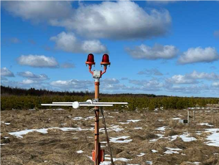
Bild 24 Södra delen inflygningsljus och monitor antenn
