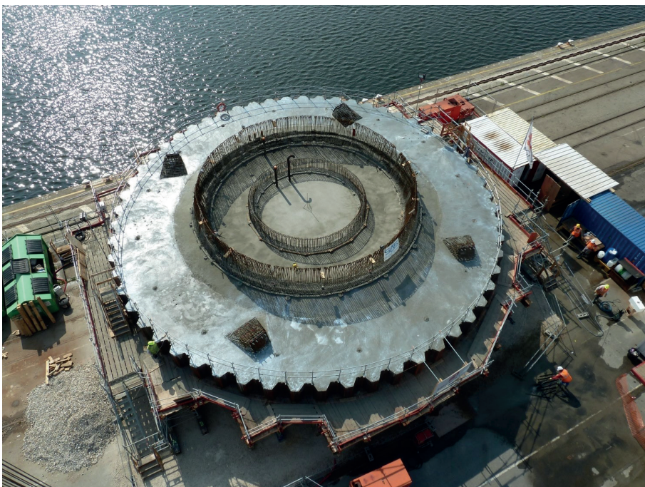
Figur 17. Visar byggnation av ett gravitationsfundament.
