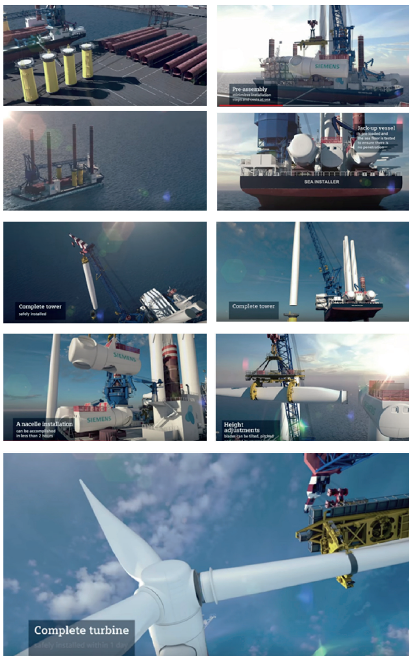
Figur 25. Bildsekvens som visar transport, installation och montering av vindkraftverk till havs. https://www.youtube.com/watch?time_continue=245&v=E02csOksyVY
