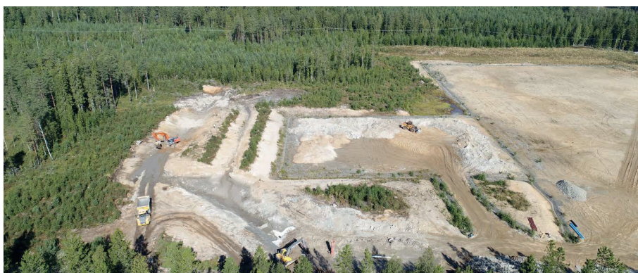
Figur 23. Pågående markarbeten vid Stamnätsstation Grönviken (420 / 145 kV).
