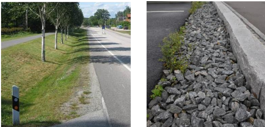
Figur 12. Exempel på svackdike och krossdike (Sweco, StormTac).
