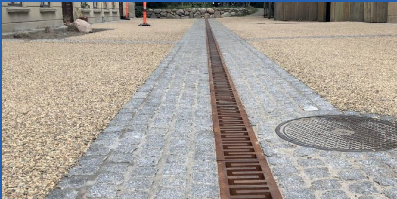
ASFALT MED INVÄLTAT GRUS, LIKA NYGATAN, AVVATTNING GENOM YTVATTENRÄNNOR
