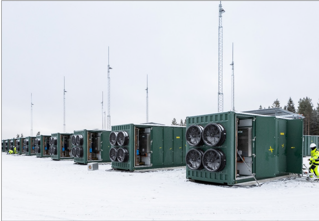
Figur 8. Bild som visar exempel på utformning av ett batterilager. Foto: OX2.
