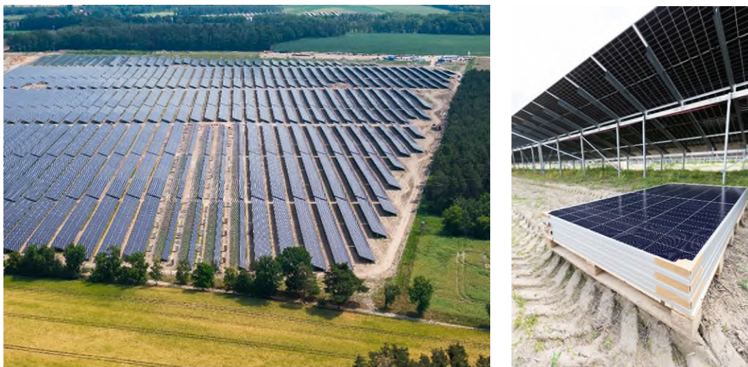
Figur 12. Exempel på montage av solpaneler på markställningar. Foto: OX2.
